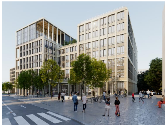
Lot E3 – Immeuble de bureaux
